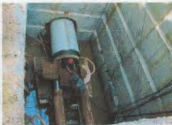
(e) 深基坑和地下管沟
