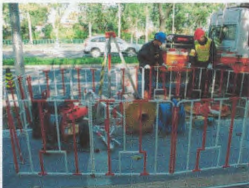
图 4-2 作业现场围挡
